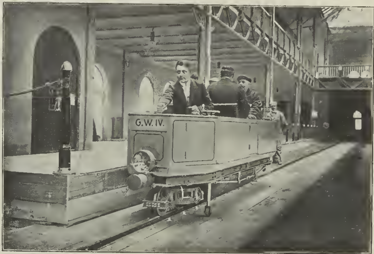
Ferrocarril de un solo riel, inventado por Ricardo Scherl y recientemente ensayado con buen éxito en Berlín (De fotografía de Carlos Delius.)
